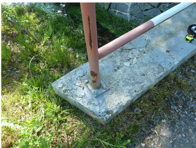
Detail římsy a zábradlí na výtoku vlevo, degradace betonu, lokálně odřené zábradlí, koroze
