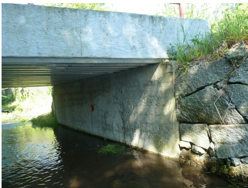
Levá opěra a napojení na regulační zed'
