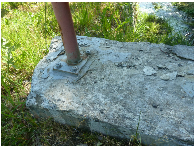
Detail degradace betonu římsy
