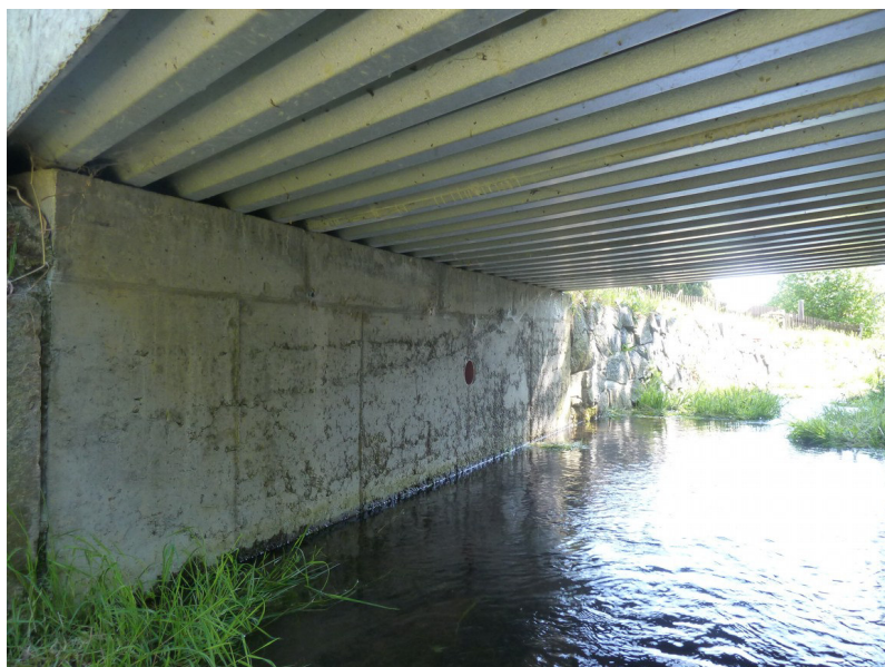
Podhled nosné konstrukce a levá opěra
